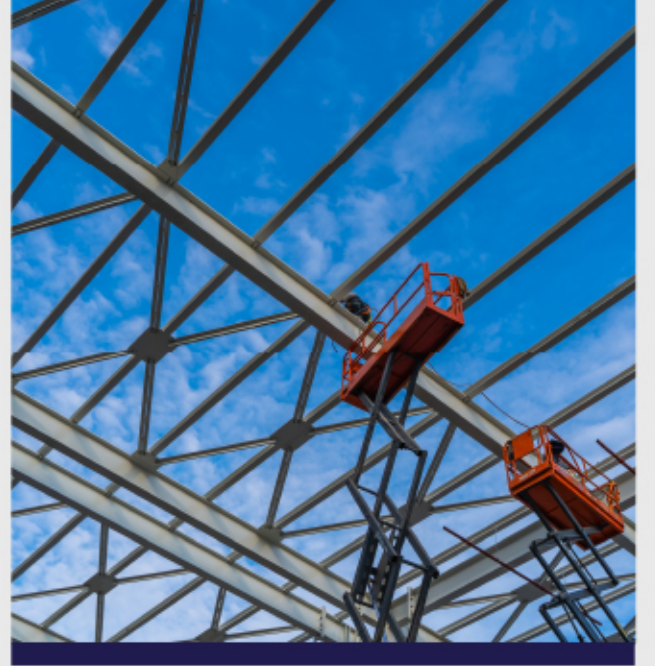
Çelik Konstrüksiyon Steel Construction
