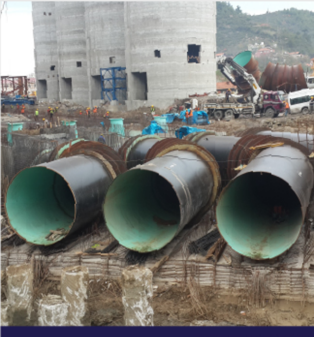
Alt ve Üst Yapı Cebri Boru Hatları Infrastructure and Superstructure Penstock Pipelines
